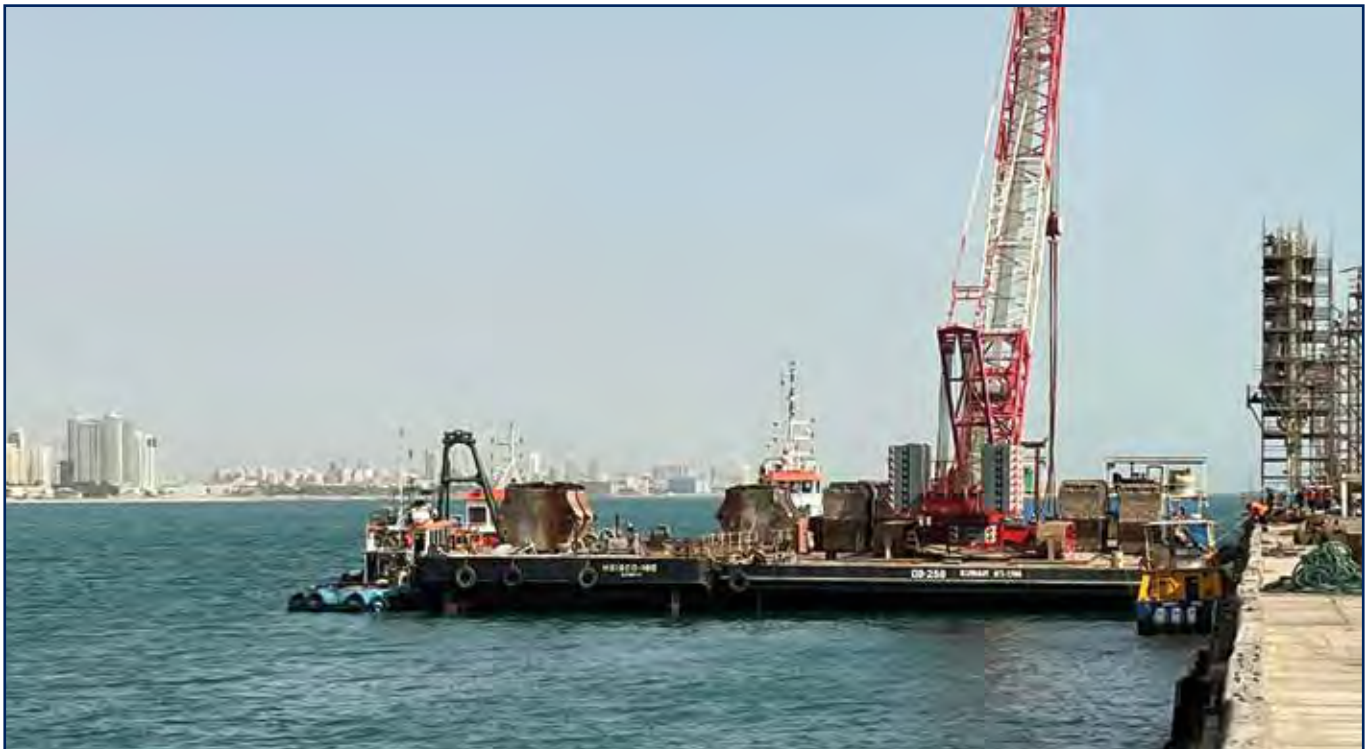
دوة متخصصة لأعمال الصيانة البحرية بمصفاة ميناء الأحمدي
