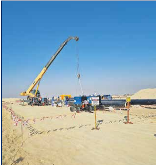
أعمال لحام الأنابيب بمشروع تحديث وتطوير شبكة الغاز والمكثفات شرق الكويت لصالح شركة نفط الكويت
