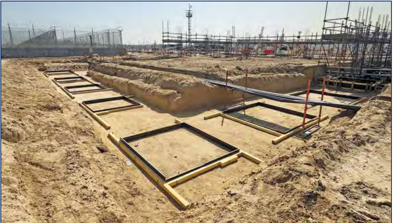
عقد أعمال التوريد والتركيب لتحديث وتطوير البوابات الأمنية في مصفاتي ميناء عبدالله وميناء الأحمدى لصالح شركة البترول الوطنية الكويتية
