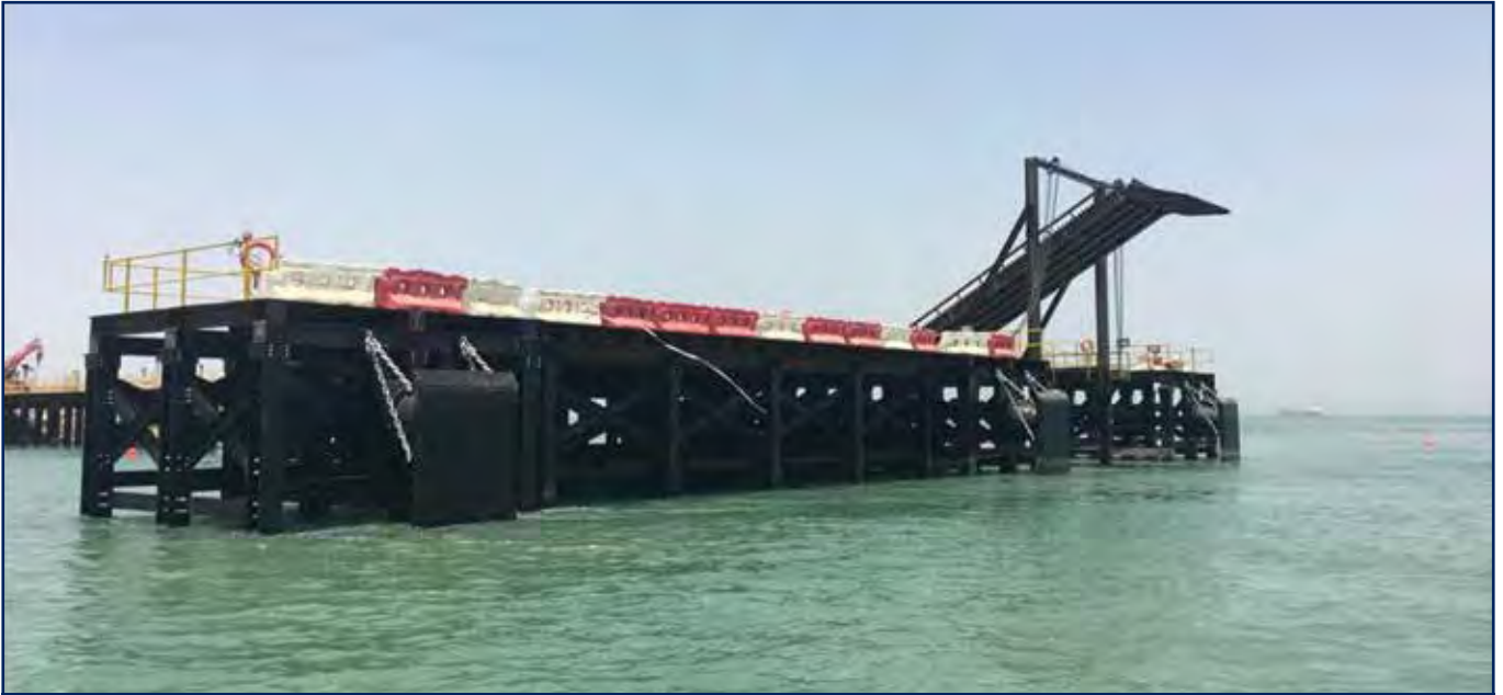
إنشاء رصيف بحري مؤقت لتفريغ المواد بمحطة راس الأرض اللوجستية
