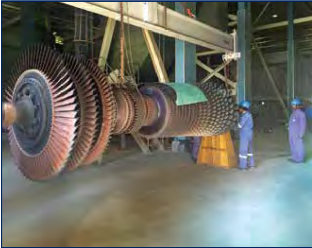
أعمال إصلاح وإعادة تأهيل موانع التسريب وقطع الغيار الميكانيكية للوحدات الغازية والدورة المشتركة ووحدات التناضح العكسي بمحطة الزور الجنوبية لتوليد القوى الكهربائية وتقطير المياه لصالح وزارة الكهرباء والماء والطاقة المتجددة.
