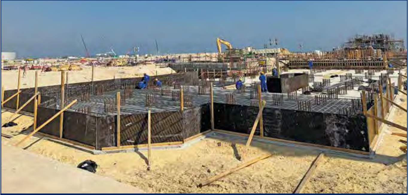
الأعمال المدنية لمشروع توسعة محطة توليد الطاقة بالدورة المركبة في منطقة القرية لصالح الشركة السعودية للكهرباء
