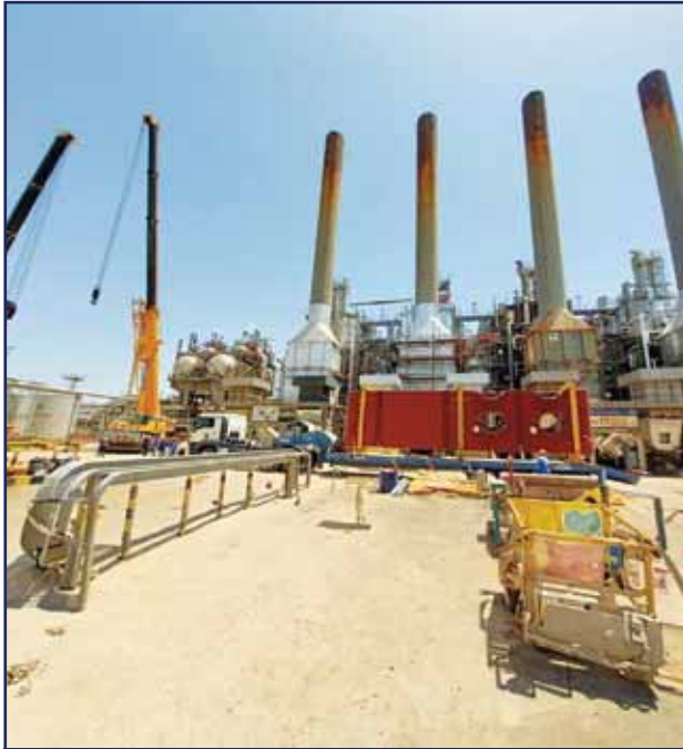
أعمال تحديث المراحل في مصفاة ميناء الأحمدية لصالح شركة البترول الوطنية الكويتية.
