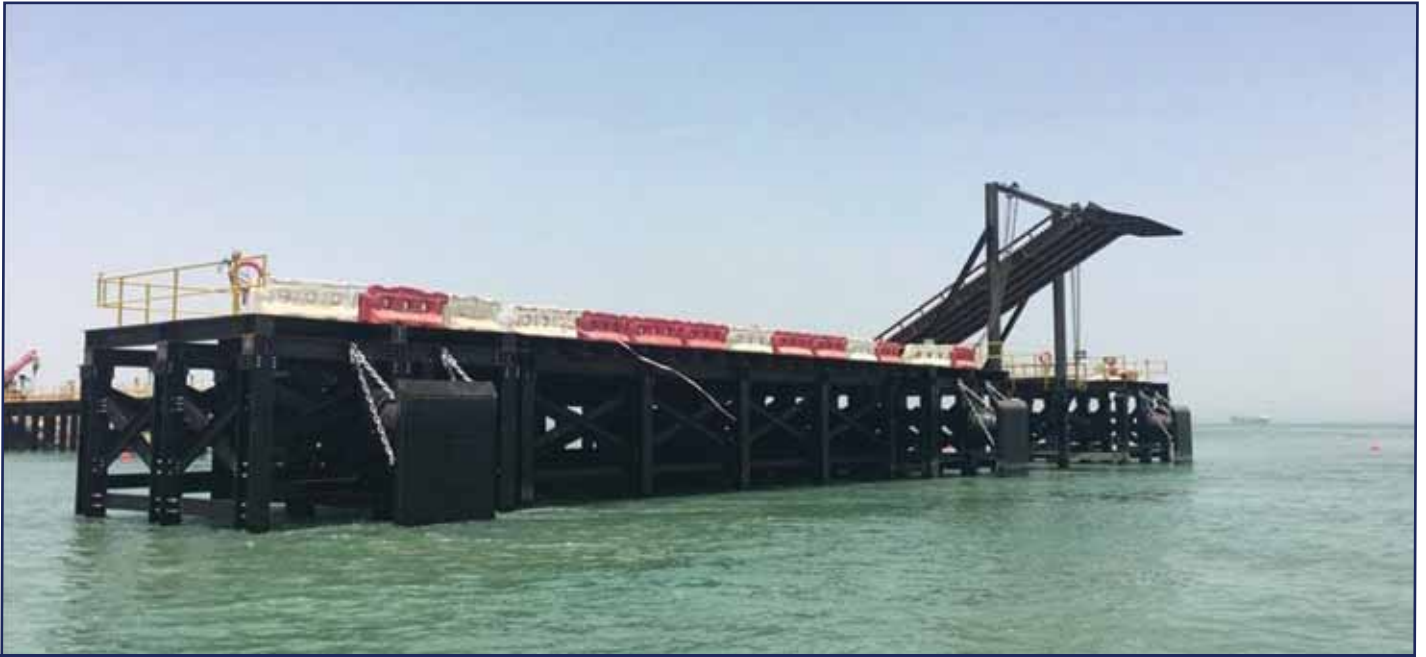
إنشاء رصيف بحري مؤقت لتفريغ المواد بمحطة رأس الأرض اللوجستية
