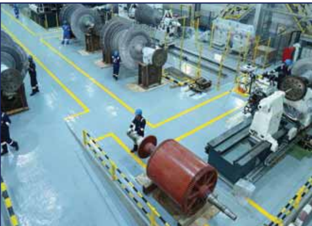
إعادة تأهيل التوربينات البخارية ومولدات الكهرباء لمحطات توليد القوى الكهربائية وتقطير المياه مع وزارة الكهرباء والماء والطاقة المتجددة.
