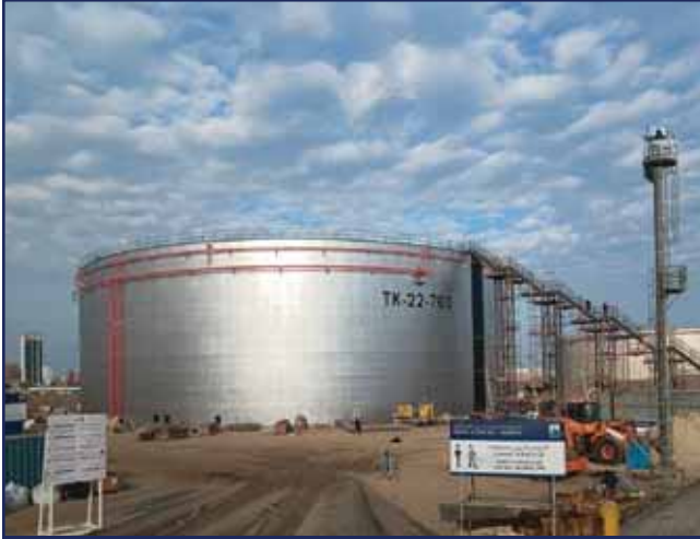
أعمال هدم وإستبدال الخزان التالف للوقود منخفض الكبريت في مصفاة ميناء الأحمدى لصالح شركة البترول الوطنية الكويتية
