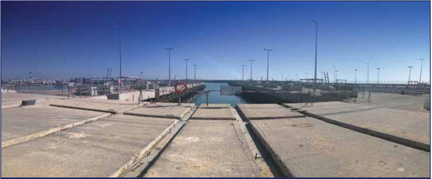
أعمال إنشاءات بحرية وإصلاحات القاعدة البحرية لصالح سلاح الهندسة للجيش الأمريكي
