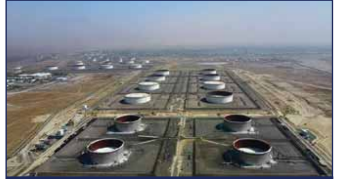
أعمال صهاريج التخزين
