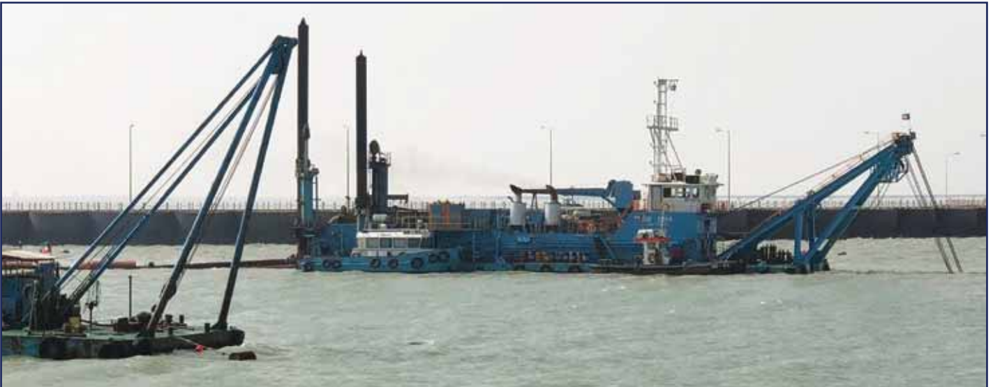
أعمال تطهير قناة مأخذ مياه البحر لمحطة الصببة لتوليد القوى الكهربائية وتقطير المياه
