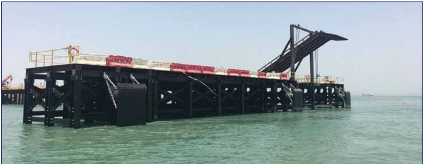
إنشاء رصيف بحري لتفريغ المواد بمرفق محطة رأس الأرض اللوجستية
